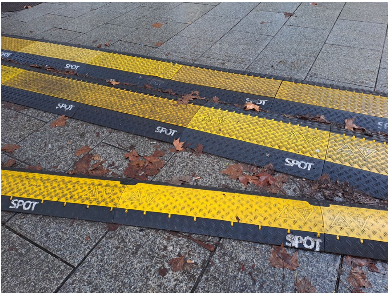
So geht es nicht! Kabelbrücken aneinandergereiht stellen ein nahezu unüberwindbares Hindernis dar.
